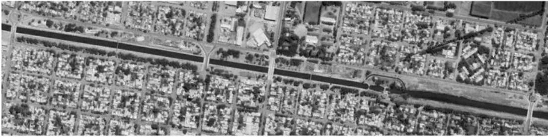
Fotografía N° 5 // Imagen aérea del 2006 - Canal Principal de Riego
