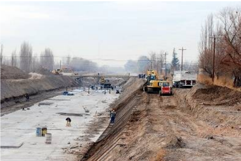
Fotografía N° 2 // Etapa inicial de las obras
